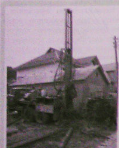
Вид на свердловину під земляний контур теплового насоса
