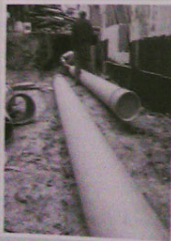
Монтаж ґрунтового теплообмінника
