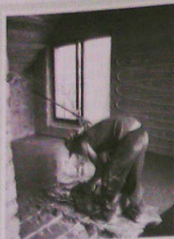
Монтаж випромінюючих тепло площин (системи опалення та охолодження будівлі)
